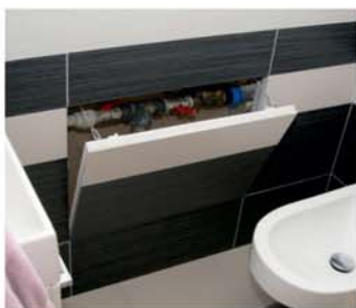
Csempével burkolt revíziós ajtó (Csempe nélkül szállítva)
